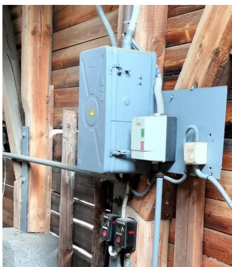
Рис. 4.3. Пульт управління сушильним цехом
