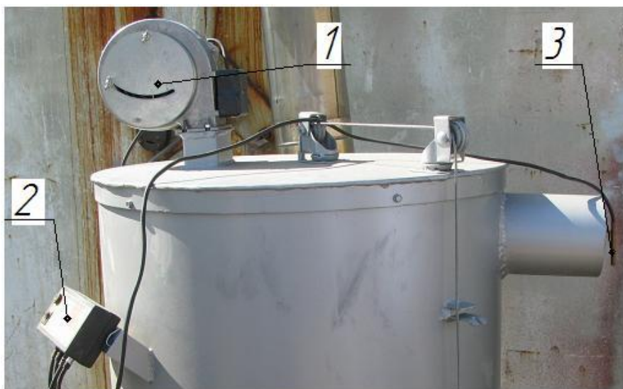
Рис. 9.19. Котел для спалювання соломи із верхнім горінням
