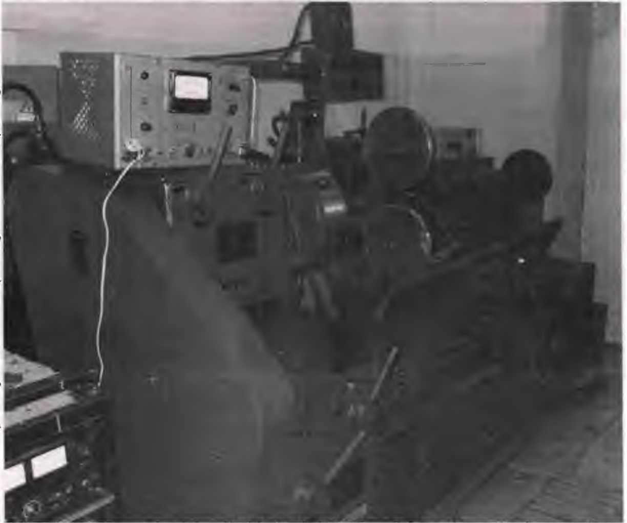
Рис. 3.1. Установка електроконтактного наплавлення
