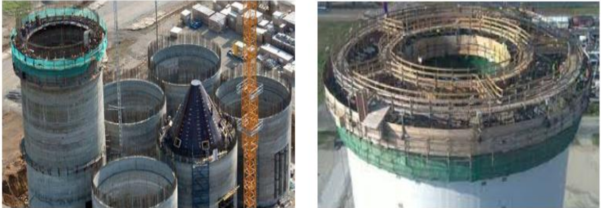
Рис. 1.4. Загальний вигляд силосних башт із монолітного залізобетону
