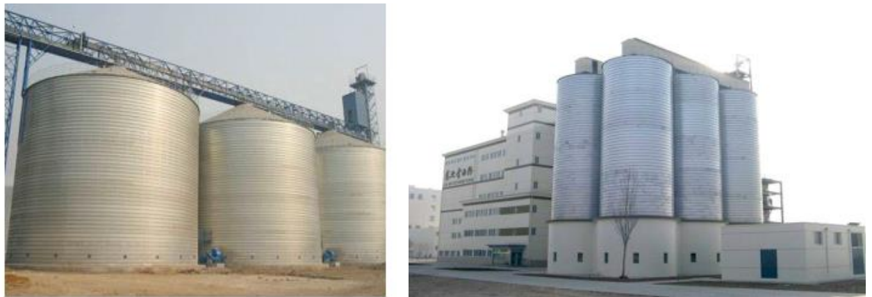
Рис. 1.9. Силосна споруда виконана за допомогою технології спірального намотування
