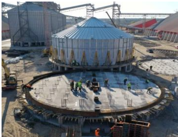
Рис. 1.6. Технологія зведення силосної споруди методом підросування з допомогою спеціального технологічного обладнання
