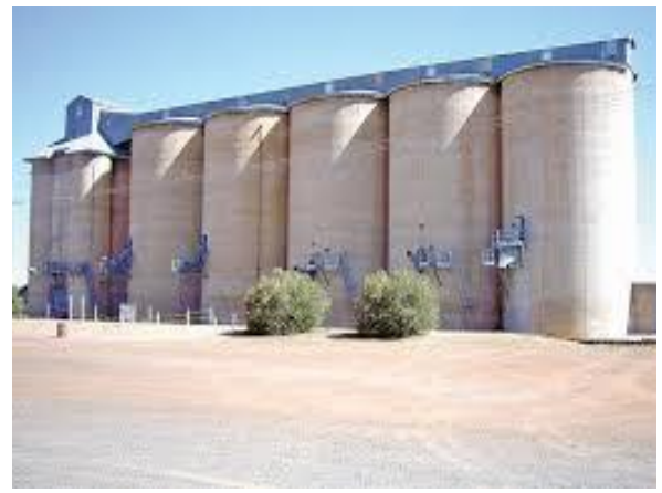
Рис. 1.1. Загальний вигляд силосів із залізобетонних конструкцій
