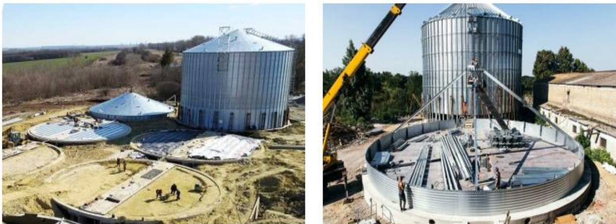
Рис. 1.5. Влаштування конструкції фундаменту та покриття силосної споруди
