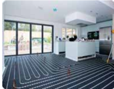
Рис. 3.16. Система Тепла підлога
