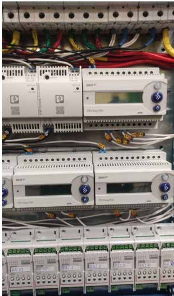
Рис. Д.9. Підключені в шафі Мікропроцесорні терморегулятори та активатори інтеграції системи відтавання снігу та льоду в шафі.
