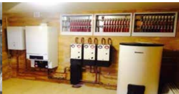
Рис. В.26. Зовнішній вигляд насосних груп теплої підлоги та конвекторів
