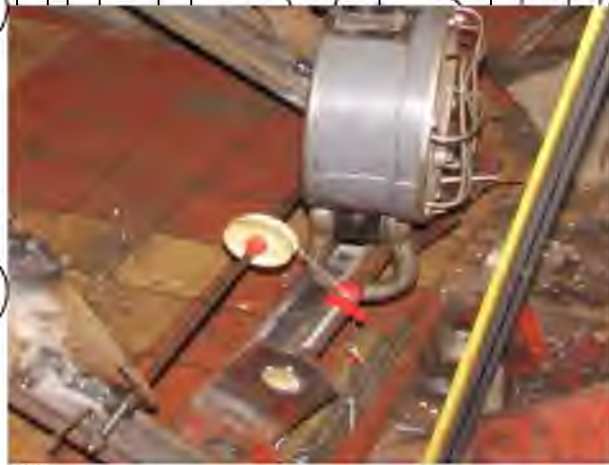
Рис. 3.11 - Контроль положення осі підвісу
